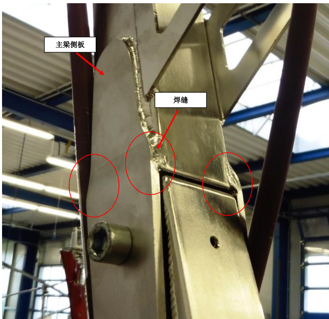
图 1:Calidus 上下主梁连接 (新)
